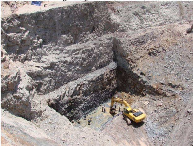
Thủy điện Sông Bung 5 – Hoàn thiện hố móng để bắt đầu thi công bê tông nhà máy (5/2011)
