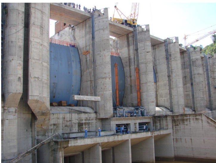
Thủy điện Sông Bung 5 – Đông công dẫn dòng (8/2012)
