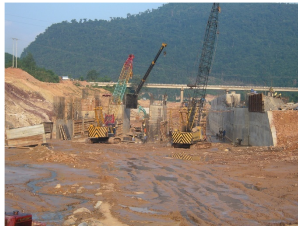
Thủy điện Sông Bung 5 – Thi công công trình dẫn dòng (10/2010)
