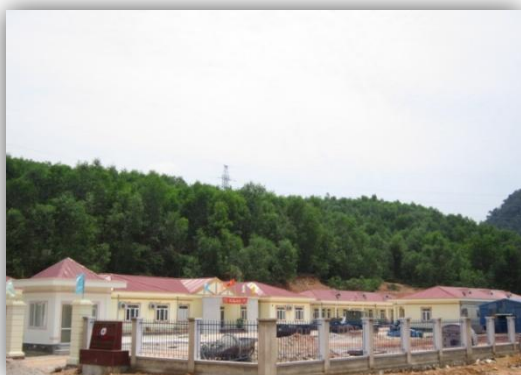
Thủy điện Sông Bung 5 Khu quản lý vận hành ( 4/2013)
