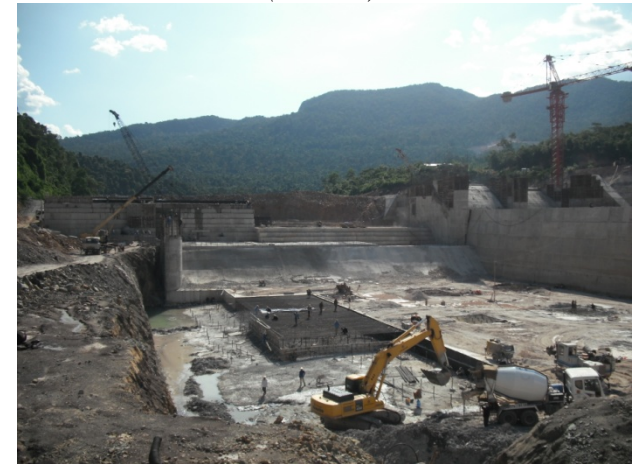
Thủy điện Sông Bung 5 – Thi công công trình bể tiêu năng (6/2011)
