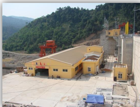
Thủy điện Sông Bung 5 – tháng 4/2013
