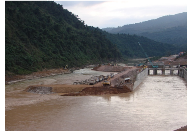
Thủy điện Sông Bung 5 – Ngăn dòng đợt 1 (2/2011)
