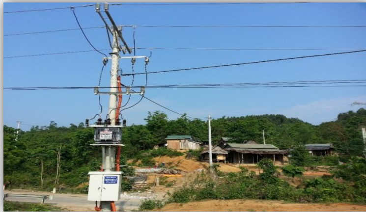
Trạm biến áp 50 kVA và đường dây được xây dựng tại thôn Pà Dấu.
