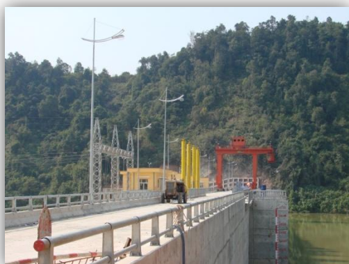
Thủy điện Sông Bung 5 – tháng 4/2013
