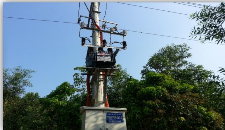
Trạm biến áp 30 kVA và đường dây được xây dựng tại thôn Pà Dấu
