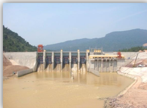
Thủy điện Sông Bung 5 Tổ máy 1 đang phát điện (4/2013)
