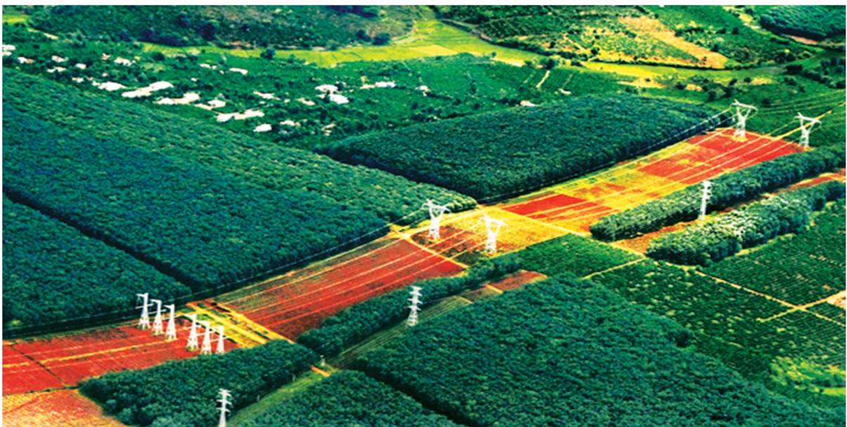
Đường dây 500kV Sơn La - Hòa Bình - Nho Quan
