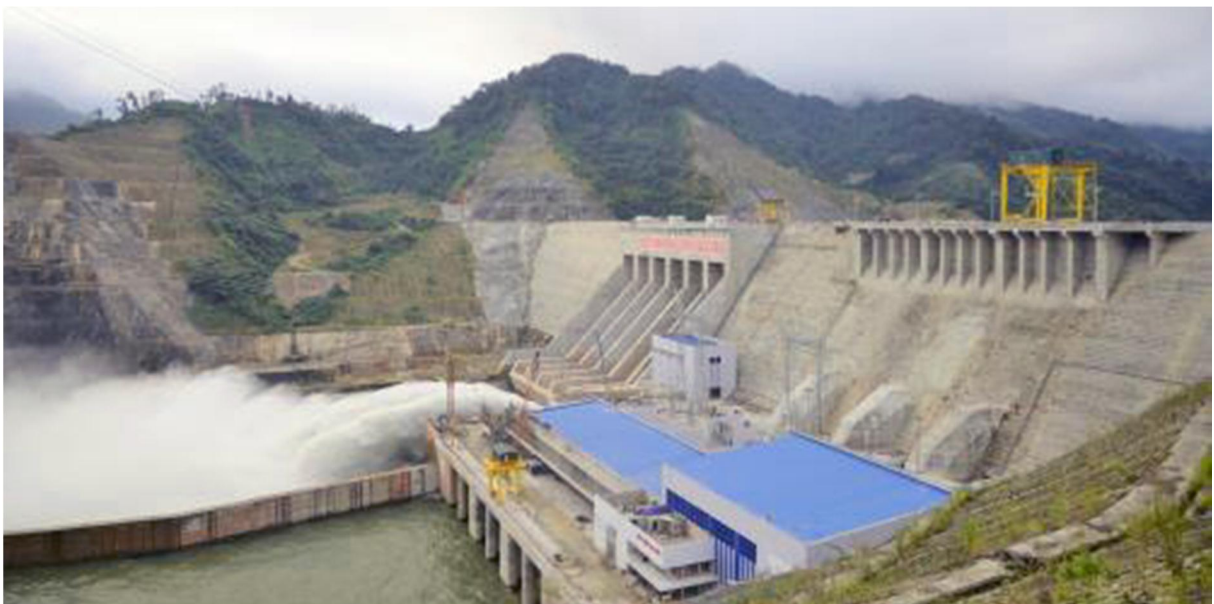
Thủy điện Lai Châu (khánh thành ngày 20/12/2016)
