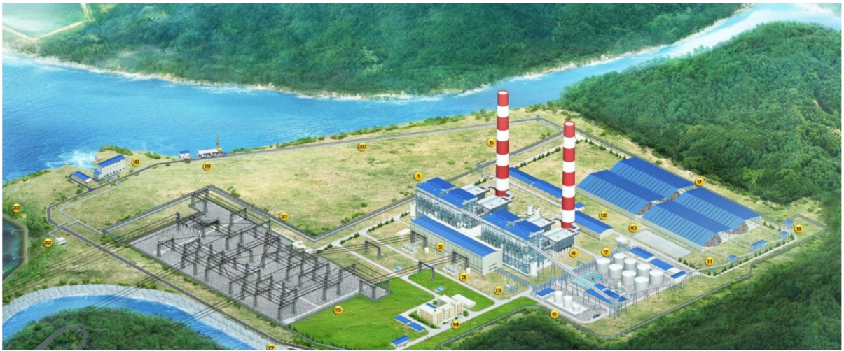
Nhà máy nhiệt điện Mông Dương 1
