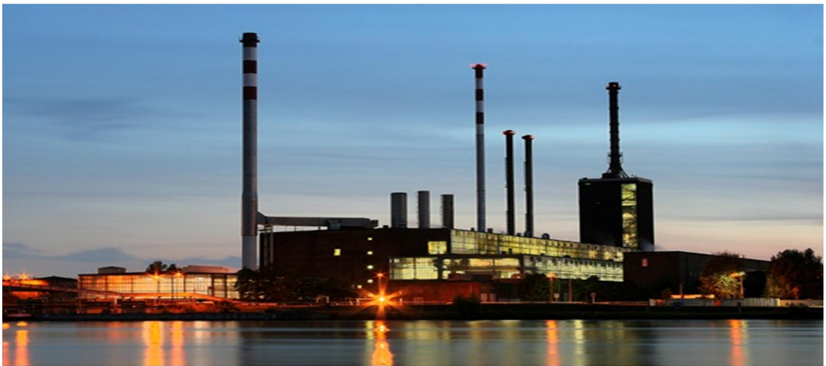
Nhà máy nhiệt điện Thái Bình 2
